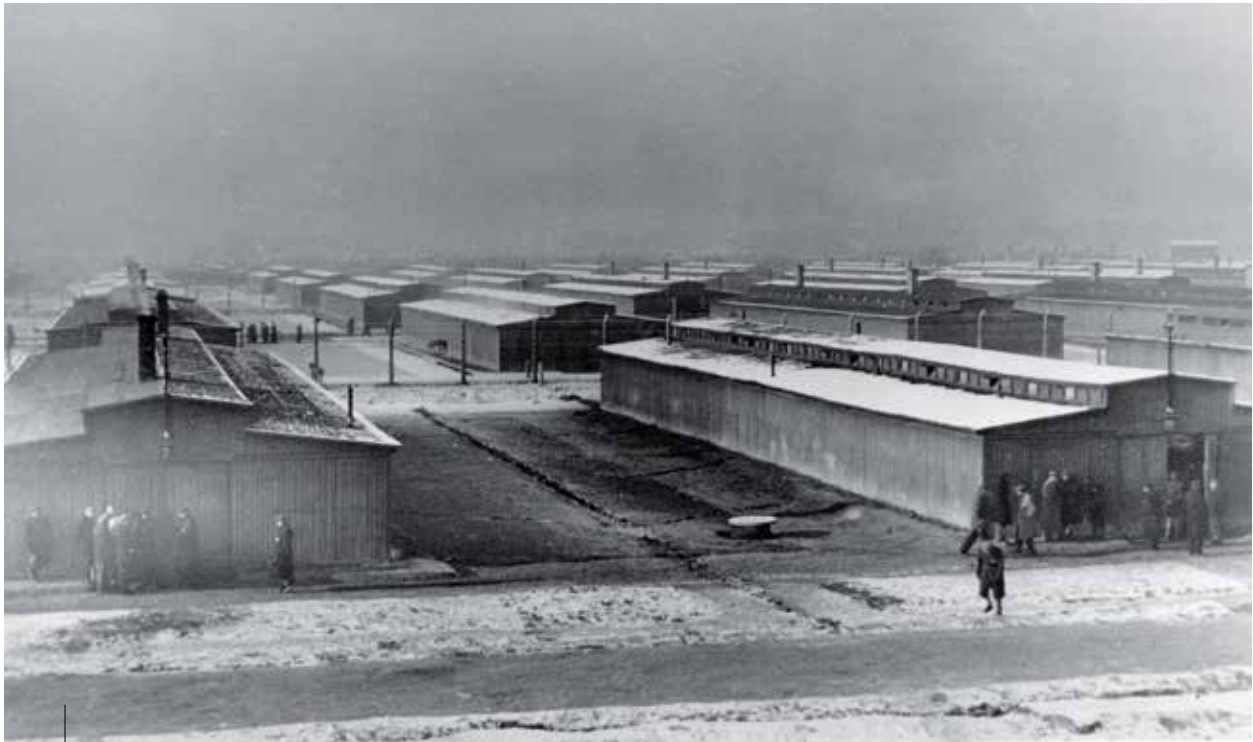
Unfassbare Zustände: Die Holzbaracken im Vernichtungslager Birkenau – von den Nationalsozialisten B II genannt – hatten keine Fenster, nur Lüftungsklappen. Der Fußboden war aus Lehm und es herrschte wegen Überbelegung drangvolle Enge.
